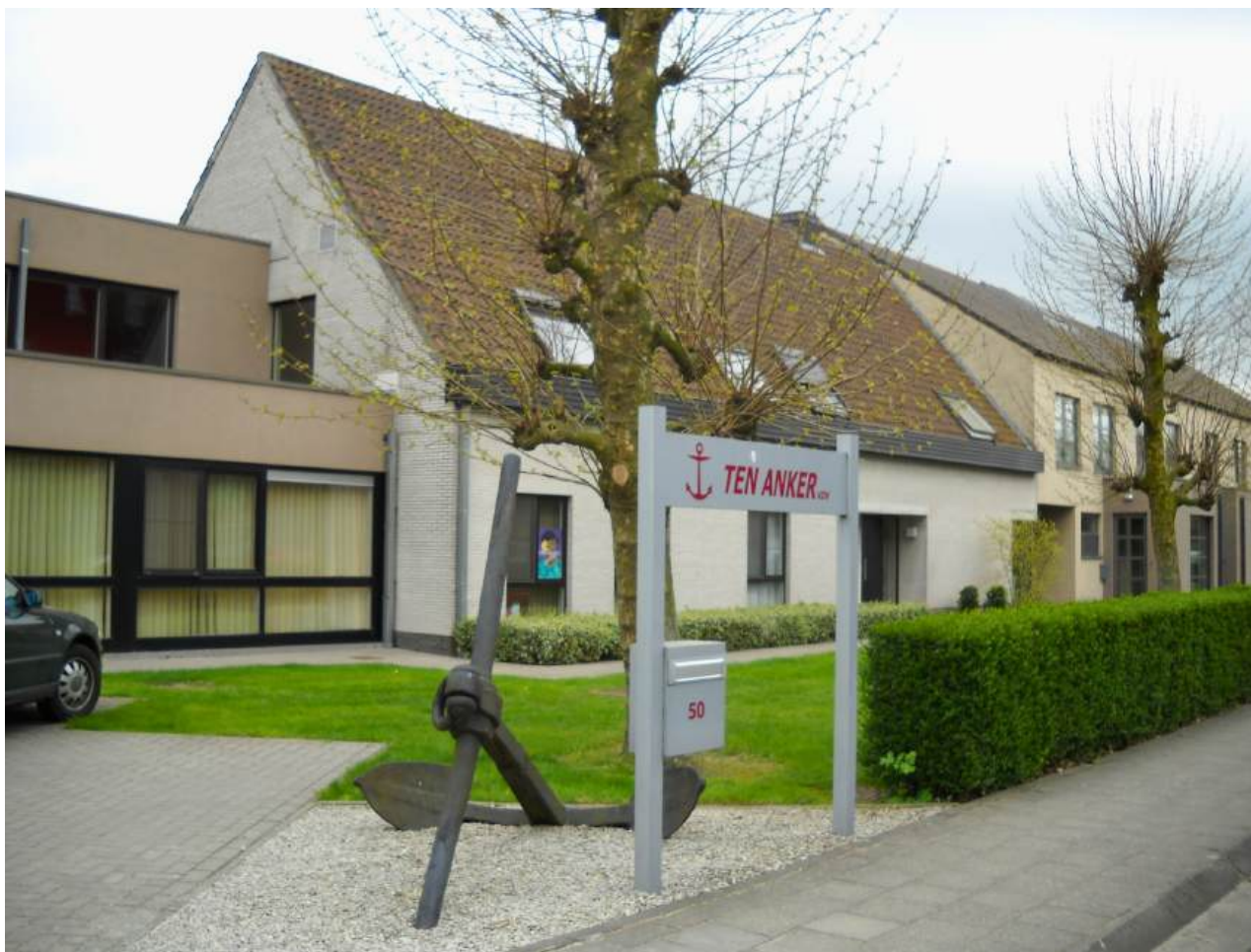
Foto - Voorgevel Zuiderlaan 50
